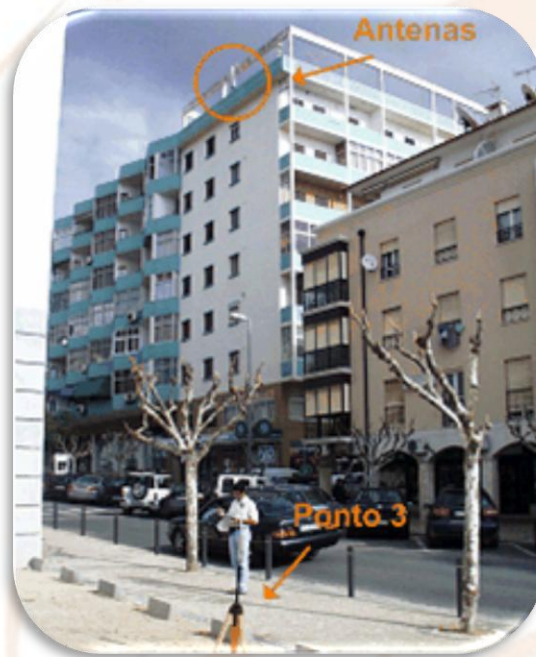
Avenida da Liberdade
